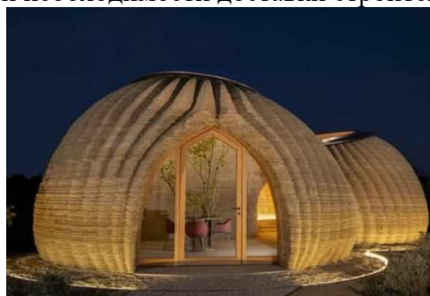
Рисунок 4 - Первый глиняный дом, напечатанный на 3D принтере
